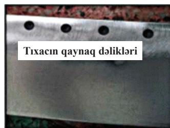
Şəkil 04-7: Yeni panelin yerləşdirilməsi əməliyyatı
