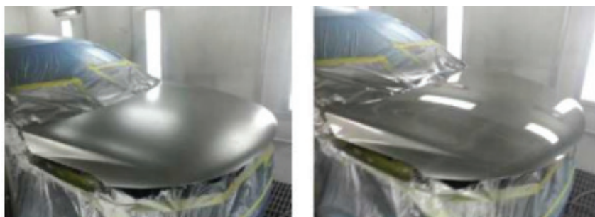
Şəkil 05-6: Kapotun əvəz edilmiş hissəsinin daxilinə və xaricinə metal əsəşli astarın çəkilməsindən sonra şəffaf astar boyasının çəkilməsi
