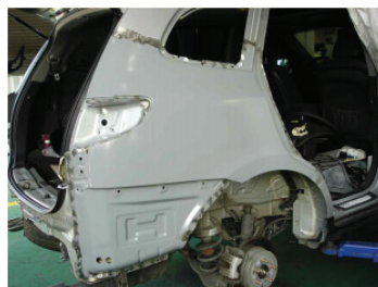
Şəkil 04-19: MIG • CO 2 qaynaq işinin başa çatması
