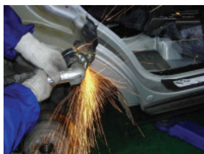
Şəkil 04-4: Panelin flans sahəsinin kəsilməsi
