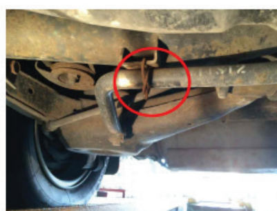
Şəkil VI, 02-8: Sabit Stabilizator Çatışmazlığı
