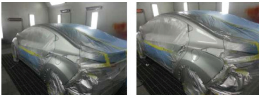
Şəkil 05-16: Arxa kapot və boğazlığın metal əsasının çəkilməsindən sonra şəffaf örtük boyasının çəkilməsi
