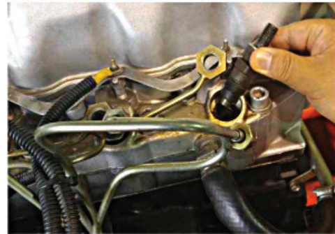
Şəkil 10-4: Püskürdücü ucluğun çıxarılması
