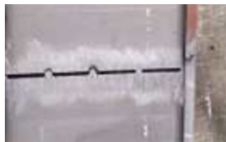
Şəkil 04-16: Mufta ilə qaynaq işi
