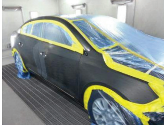
Şəkil 04-3: Kənar lövhənin boyanması zamanı qoruyucu örtük çəkilməsi
